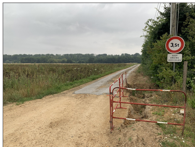
Visibilité en sortie de carrière, à droite
